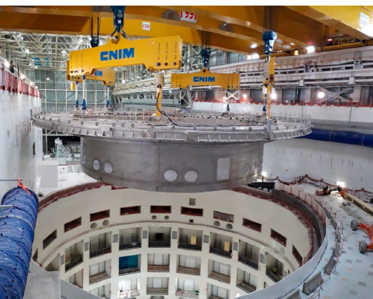
Manutention de la base du cryostat, la pièce la plus lourde d'ITER avec ses 1250 tonnes.
