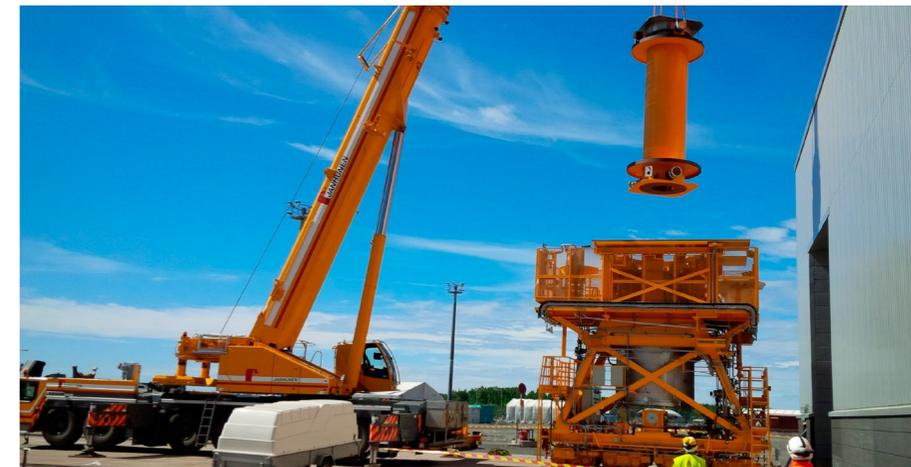
Essai en charge du chariot de manutention du combustible utilisé sur l'EPR OL3
