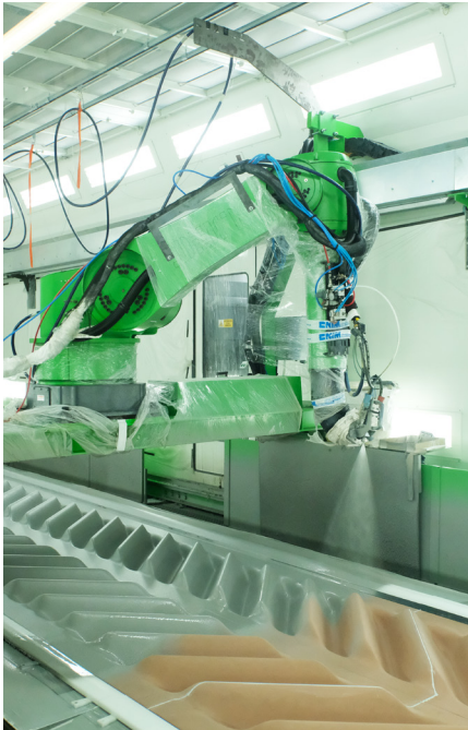
Pulvérisation robotisée de polyuréthane.
